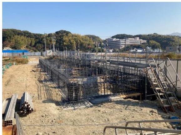
鉄筋足場組立工現場写真②
