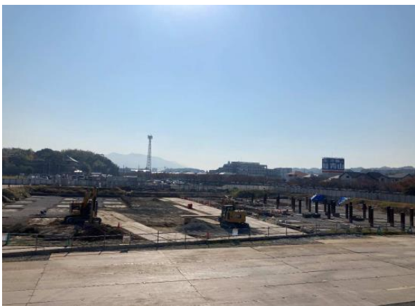
鉄筋足場組立工現場写真①
