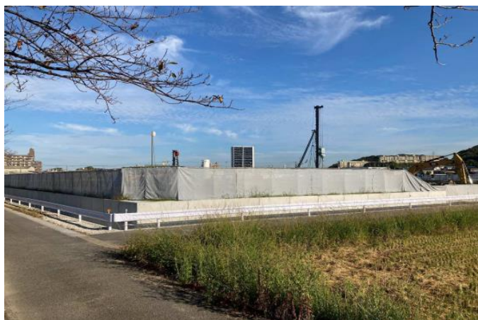
杭施工現場写真②
