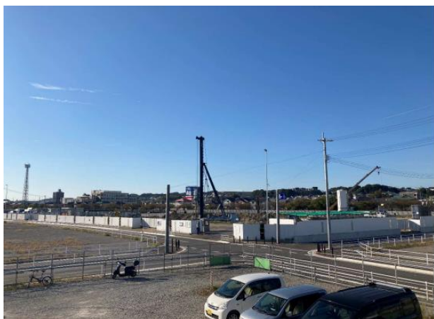
杭施工現場写真①
